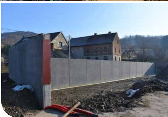
Chez Chêne Travaux, le mur de la berge s'est effondré à l'arrière du site. C'est par là que l'eau s'est engouffrée. Comme vous le voyez sur la photo (à dr.), ce mur a été reconstruit.
